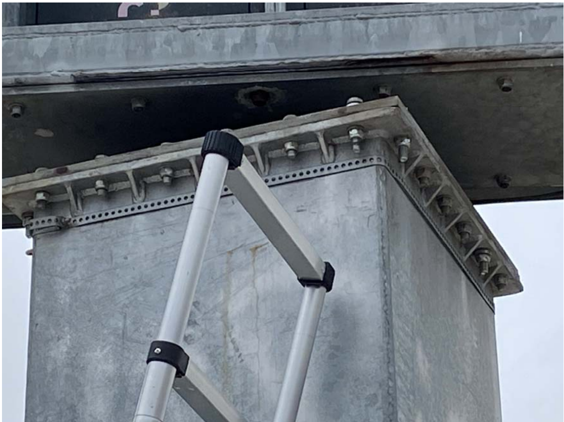
Városligeti műlyégpálya Ledpanel- és tartószerkezet forgástengely kapcsolata 4 / 8 - 2025-04-15
